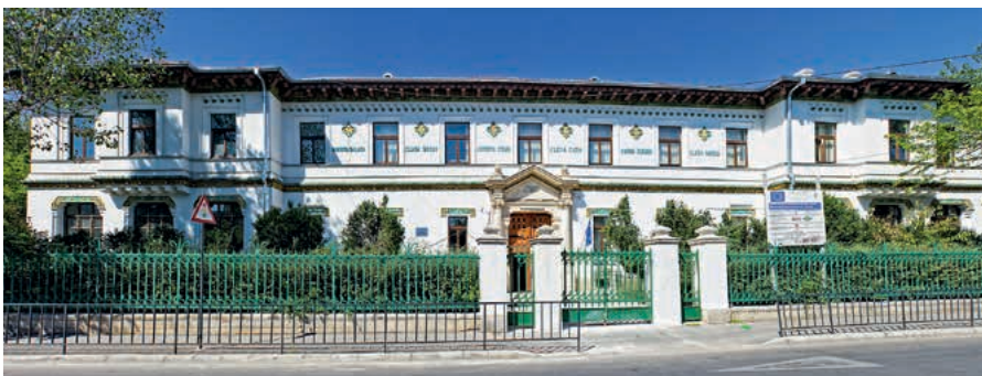
Școala Centrală de Fete, București, 1890, operă a arhitectului Ion Mincu.
